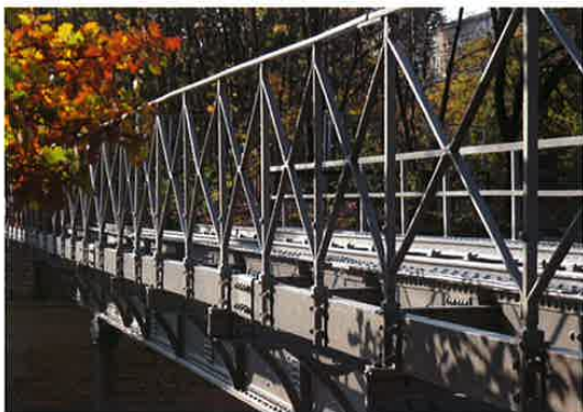
22. Yorckbrücke Nr. 5 nach der Instandsetzung. Foto: Lorenz & Co. Bauingenieure.
