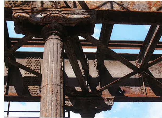
17. Yorckbrücke Nr. 5, Details am Stützenauflager, Zustand 2011. Foto: Lorenz & Co. Bauingenieure.
