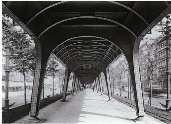
8. Untersicht des Viadukts mit alternierenden Kragrahmen und Einhängerträgern, 1. Bauabschnitt 1909-13, Aufnahme vor 1920 [Wittig, Die Architektur der Hoch- und Untergrundbahn in Berlin, 1922].
