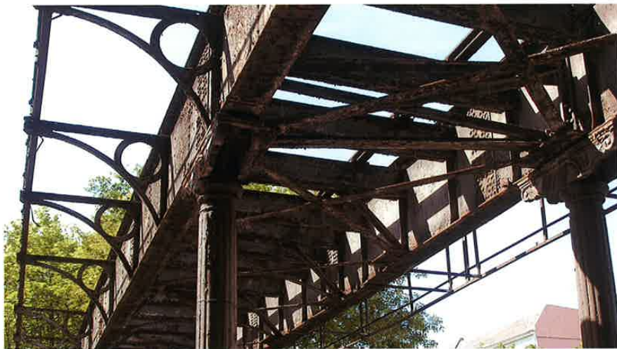
16. Yorckbrücke Nr. 5, Durchlaufträger als Deckbrücke in „offener Bauweise“, 1875, Zustand 2011. Foto: Lorenz & Co. Bauingenieure.
